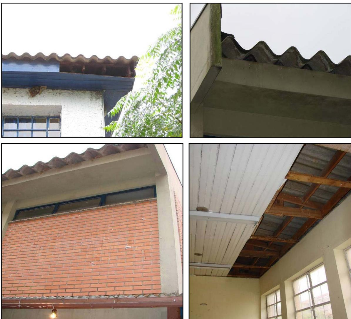
1. Aba de madeira danificada, propiciando acesso dos pombos ao interior do telhado (E. E. de E. F. Genoveva da Costa Bernardes). 2. Telhado com calhetas sobre chapa de alvenaria; os pombos entram no telhado pelos vãos entre as telhas e a chapa (E. E. Mons. Leopoldo Hoff). 3. Outra vista da mesma escola. 4. Forro de teto danificado, causando a queda de sujeira e fezes para dentro da sala de aula; os pombos entram por vãos do telhado (E. E. de E. F. Evaristo Gonçalves Netto).
